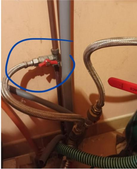
Mettre perpendiculaire % au tuyau pour fermer
